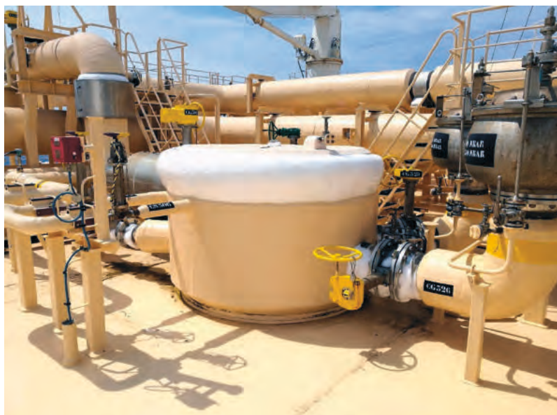
Rys. 47. Kopuła gazu zbiornika ładunkowego widziana od strony pokładu / gas dome view from main deck
