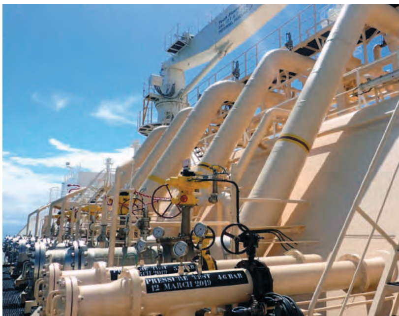
Rys. 78. Manifold ładunkowy statku LNG / LNG vessel manifold
