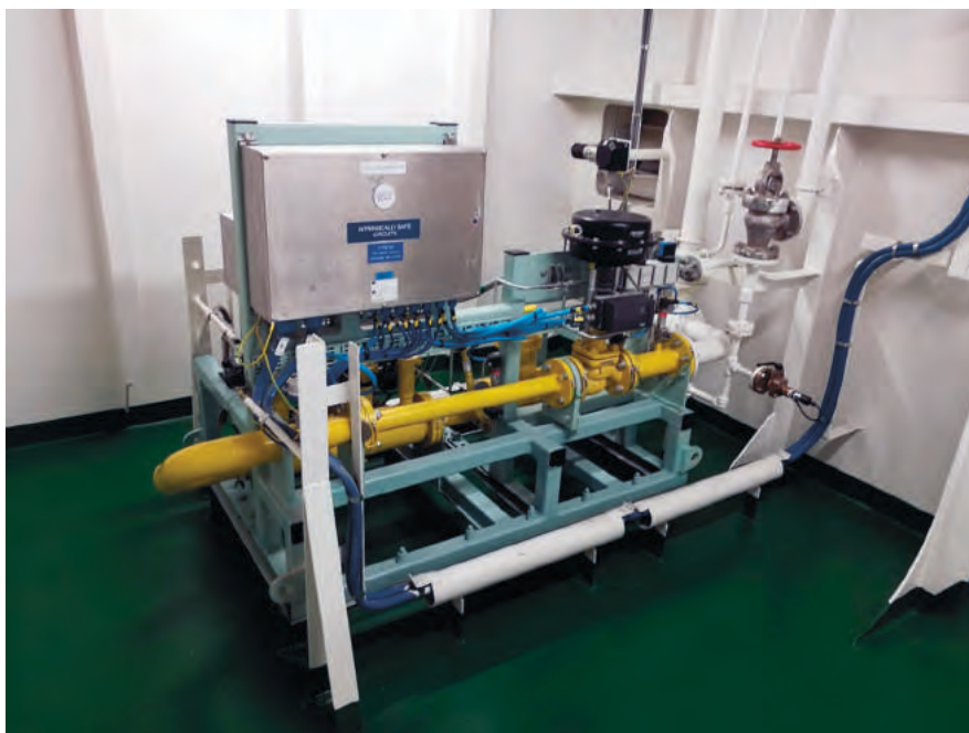
Rys. 52. Urządzenie kontrolujące przepływ gazu do silników pomocniczych DFDE / gas valve unit
