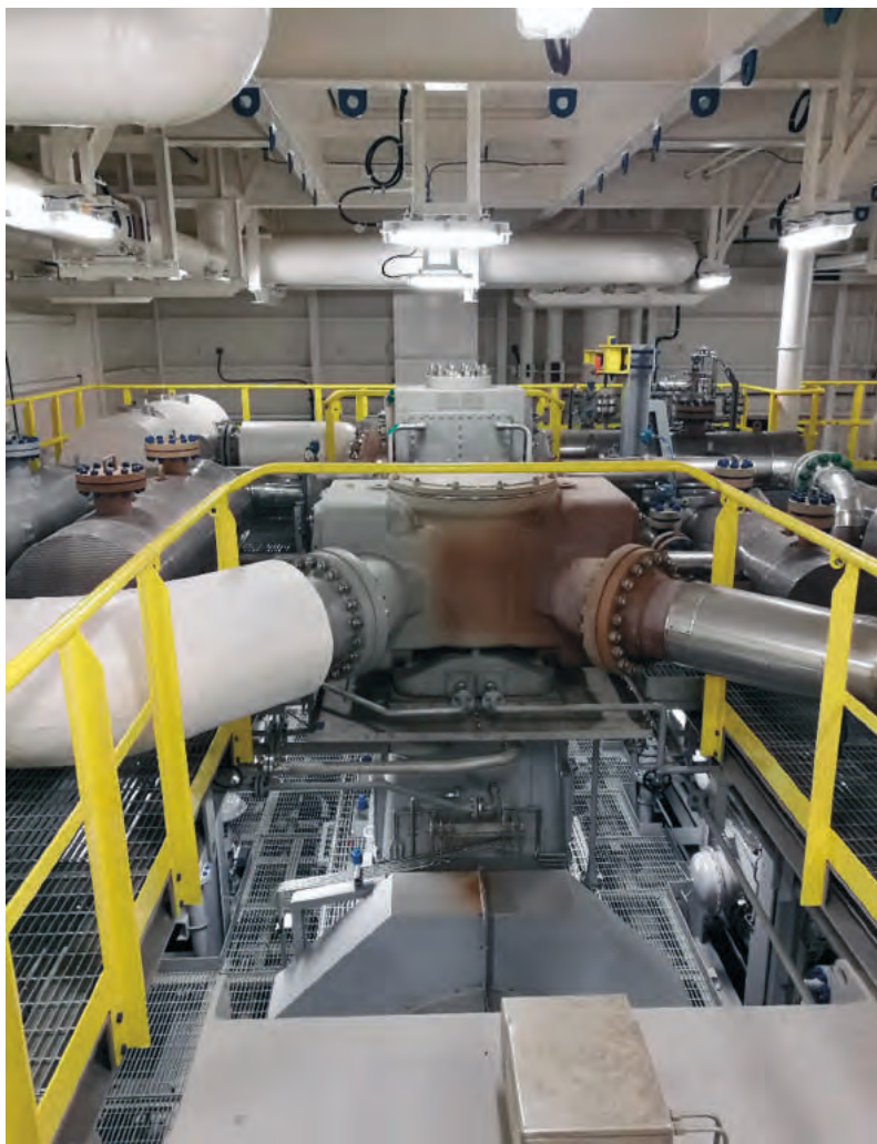
Rys. 56. Widok z górnego podestu ukazujący głowice poszczególnych stopni sprężarki / HiCOM cylinder heads
